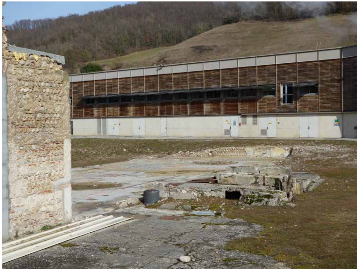
Emplacement de la turbine lors de la destruction de 2021. Le canal passe dessous.
