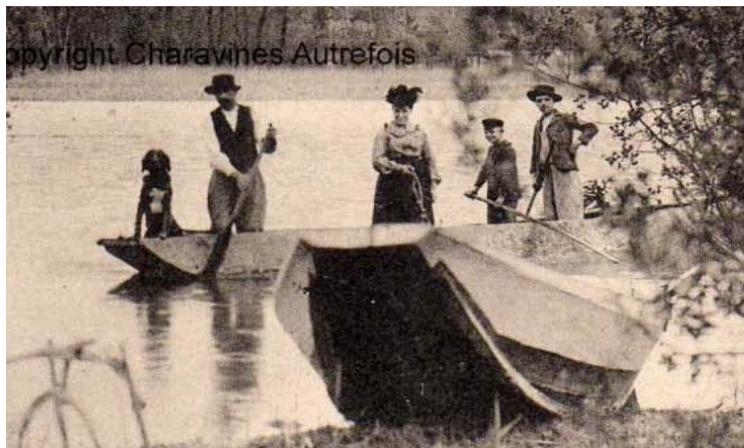
Avec l'essor du tourisme et de la pêche amateur on a construit des barquettes plus légères qui pouvaient être menées à l'aviron par un pêcheur local ou offertes à la location. Le tableau arrière rectangulaire légèrement incliné est une caractéristique particulière de ce type de construction. La tonture marquée est due à l'évasement du bord au milieu du bateau.
